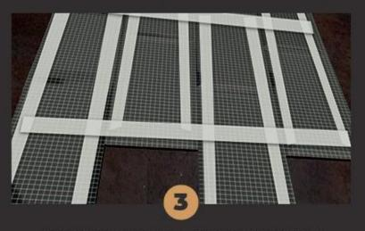
Para assentar, utilize adesivo (substância fixadora) como silicone de cura neutra, fixa espelho, ou fita dupla face, isenta de solventes. Aplique adesivo/fita em cada peça, mesmo para o produto telado, sempre na vertical para evitar umidade no revestimento e permitir a circulação de ar, respeitando um espaço de 3mm entre a parede e o revestimento. Não utilize argamassa no assentamento.
