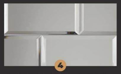
Caso necessário, corte as peças com cortador próprio para vidros e espelhos. Para peça avulsa, recomenda-se junta seca - técnica para instalar ou assentar revestimento sem rejunte. Para os espelhos telados, deve-se utilizar espaçador de 1,5mm entre todas as peças de espelho. NÃO aconselhamos rejuntar. Caso queira rejuntar, consulte um fabricante de rejunte.
