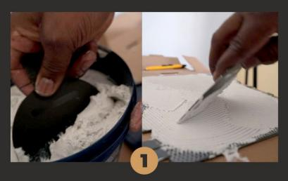
Para instalação desses produtos utilizar argamassa acrílica branca com ph neutro. Não utilizar argamassa, cola ou rejunte com base cimentícia. Não damos garantia contra oxidação.
