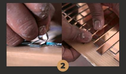
Caso necessário, corte as peças com cortador próprio para vidro. Consultar fabricante da argamassa/cola/rejunte.
