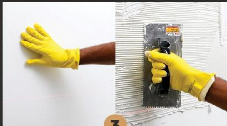
A superfície deve estar limpa e nivelada, livre de umidade. Na sequência aplique a argamassa em ângulo de 60° graus, em quantidade suficiente para assentar de 3 a 4 placas por vez.
