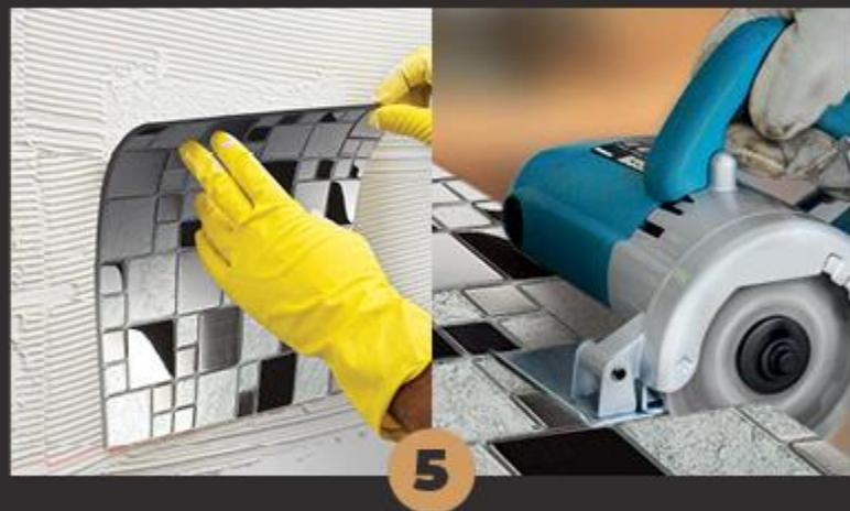
5 Aplique a pastilha sempre com a parte telada voltada para a parede, com o auxílio do prumo tradicional ou a laser, ilustrado na imagem através da linha vermelha. Para recortes, utilize a serra circular com um disco de corte próprio para aço inox.
