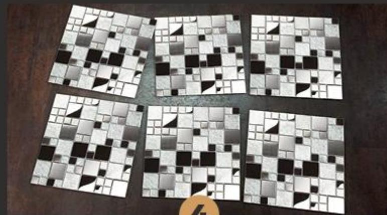
Monte no chão um painel com placas de diferentes embalagens, assim será possível comparar as tonalidades das peças e qualquer não conformidade antes do assentamento. O Instalador deve prever uma sobra em torno de 5% a 10% para recortes e reserva preventiva.
