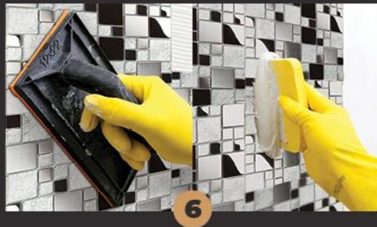
6 Após a pastilha assentada, com o auxílio de uma desempenadeira de borracha, passe o rejunte na parte frontal com um aplicador de rejunte. Preencha as juntas, remova o excesso antes de endurecer. Utilizar espátula de EVA, se necessário. O rejunte não poderá conter areia em sua composição. Cuidado com o rejunte utilizado para não riscar as pastilhas de aço inox. Além disso, o rejunte deverá ser flexível, impermeável e de boa aderência aos metais. Consulte o fabricante.
