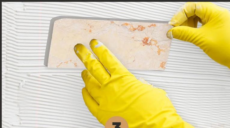
Aplice a argamassa no verso do tijolo preenchendo corretamente e retirando o excesso. Em seguida aplique a argamassa na parede, com o lado liso da desempenadeira, frisando com o lado dentado. Cuidado para não aplicar em excesso. O tijolo de mármore Glass Mosaic pode ser assentado com junta seca, sem rejunte. Porém em paredes maiores, recomendamos a utilização de junta de dilatação a cada 4/5 metros e espaços entre o revestimento, obstáculos como paredes perpendiculares e colunas.
