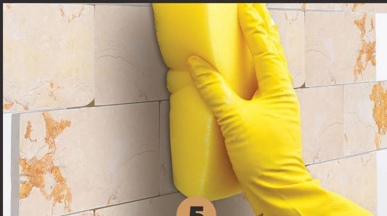
Remova o excesso da argamassa com esponja semi-úmida e, se necessário complete com desempenadeira de borracha. Após a secagem, proceder a limpeza final com esponja ou pano seco. A cor e a textura das pedras naturais podem variar de acordo com as condições climáticas.
