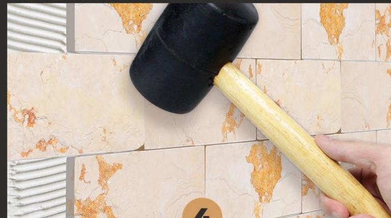
Com o auxílio de um nível, prumo tradicional ou a laser, aplique o tijolo na superfície, utilizando um martelo de borracha para bater suavemente com o objetivo de obter uma melhor planicidade.
